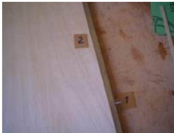
découpe des bandes : en 1, clous pour plaquer le ctp; en 2, plat de laiton large de 7 mm
