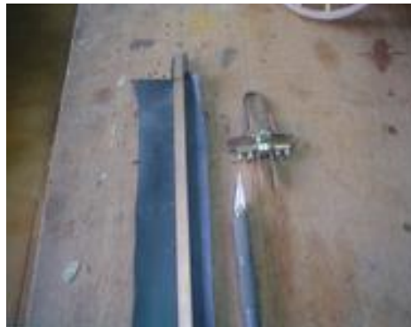
Chantier : les lames viendront de part et d'autre du réglet.
