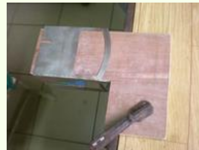
chantier de soudure
