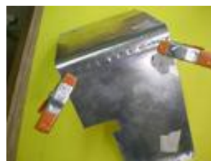
Si on a mis suffisamment de mastic, il ressort un peu au serrage des pinces par les trous supérieurs ; enfilez les clous.
