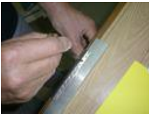
Tracer l'emplacement des trous puis pointer en interposant un plat d'alu.
